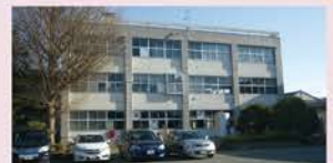
移転した理科棟
