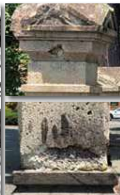
劣化・芯ずれの発生した現在の姿
