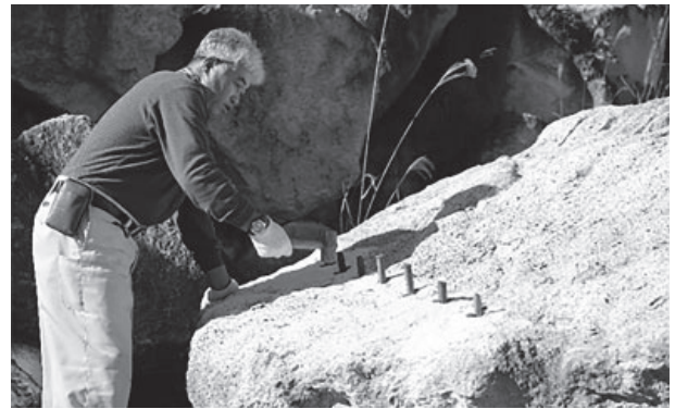
楔打ち作業R4.11.8
