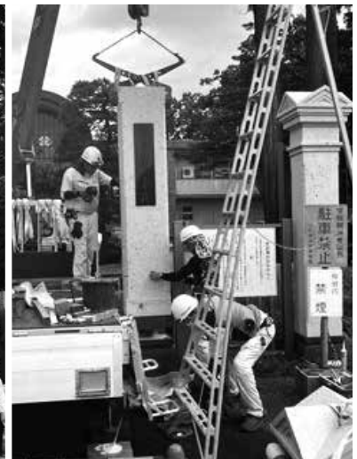
正柱の設置作業（7/29）
